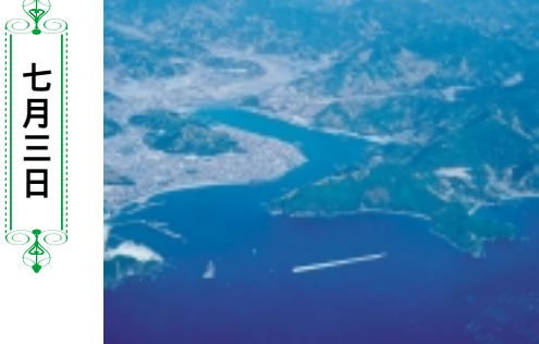
須崎港沖の防潮堤
