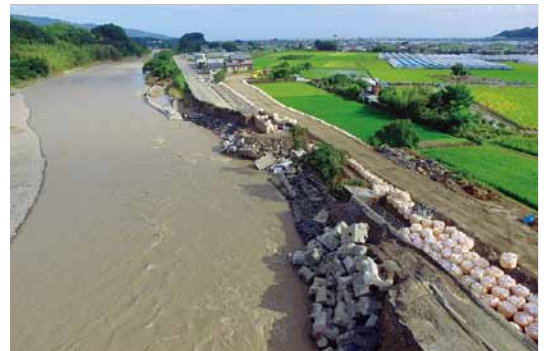
7月豪雨での安芸川の被災状況
