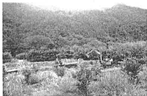
ユズ園に流入した土砂除去作業 (8月20日～)
