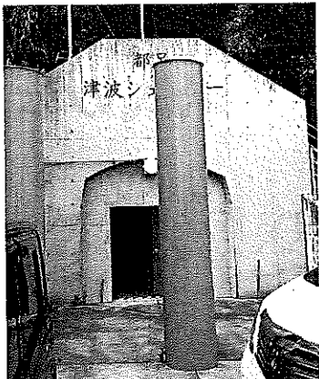
都呂地区の津波避難シェルター
