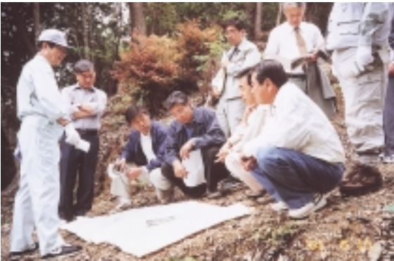
日高村のエコサイクルセンター建設予定地を視察
