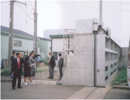
高潮対策事業を視察(北海道浜中町)
