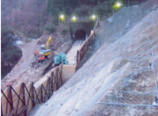
土佐くろしお鉄道・中村線の土砂崩れ復旧工事 (佐賀町荷福)
