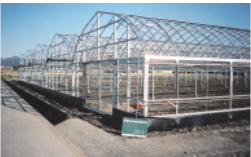
レンタルハウス整備事業(土佐山田町)
