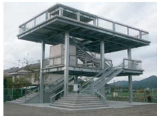
津波避難タワー（黒潮町）
