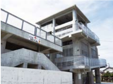
津波の際、避難空間となる避難タワー(南国市)
