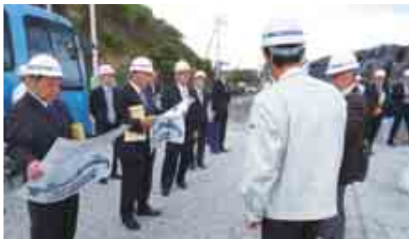
インプラント堤防の工事現場（高知市長浜）
