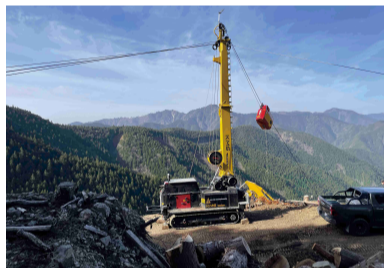
高性能林業機械(タワーヤード)
